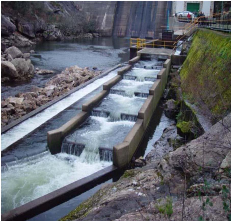
**Mantenimiento de un caudal ecológico adecuado, habilitado aguas abajo de la presa de Barrié de la Maza**
